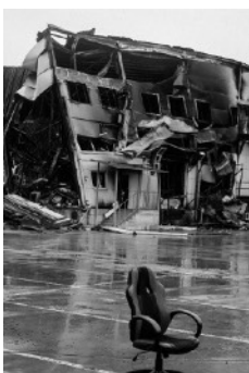
Зруйнований торговий центр. Зйомки тривали під час бою. Березень 2022 р
